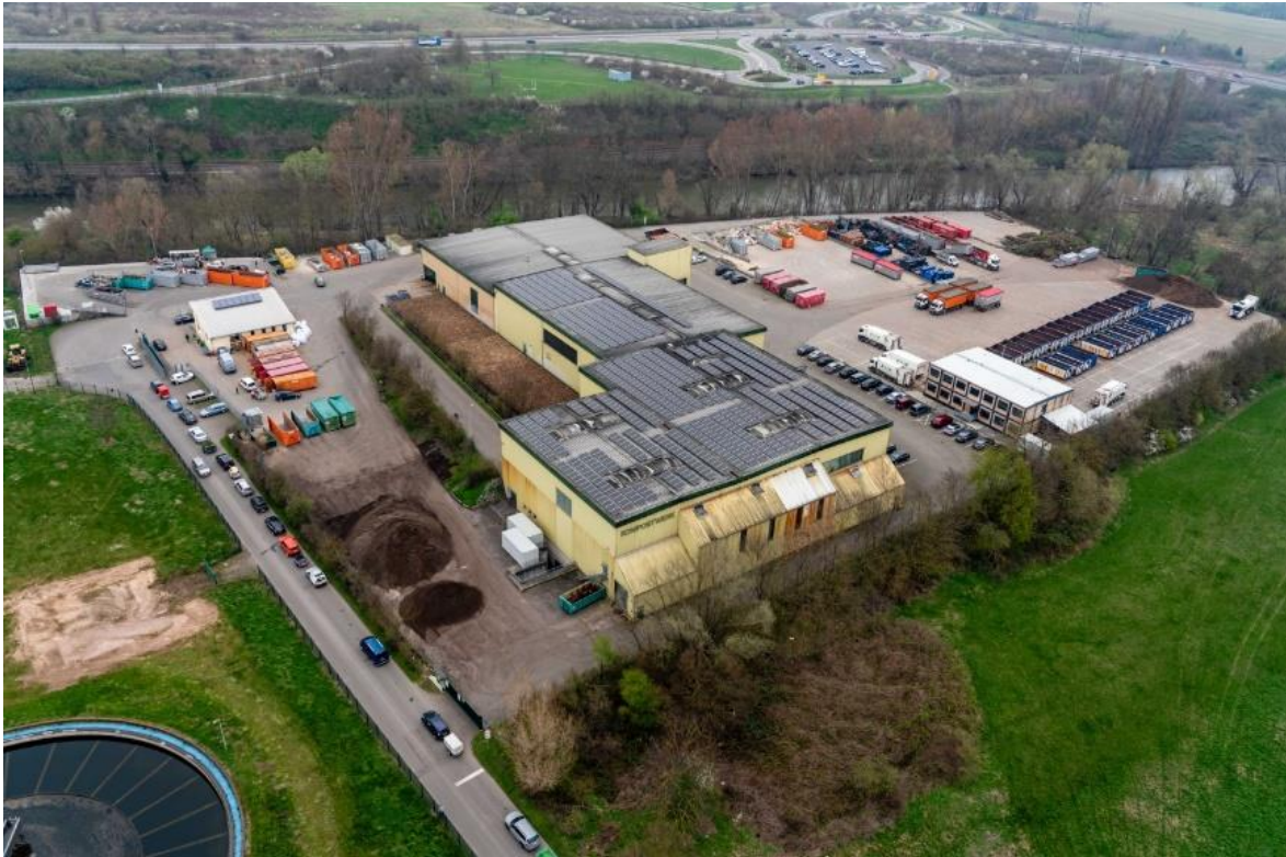
Abbildung 8: Kompostwerk/Umladestation Bad Kreuznach (links: Wertstoffhof und Eingangsbereich; rechts: Fuhrpark und die Containerkompostierung)
